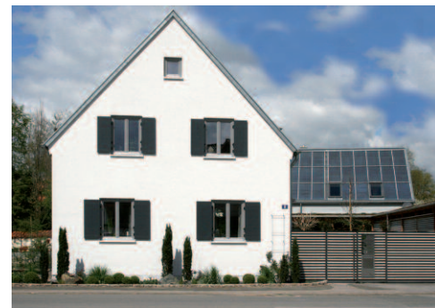
Neubau als Passivhaus im dezenten Stil.
